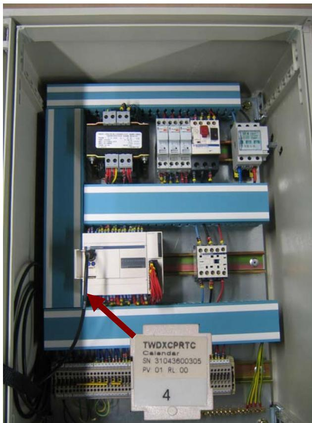
En Photo ci-contre, nous avons l'armoire électrique ouverte. Sous l'automate en partie inférieure gauche, si l'on soulève la façade vers le haut, on verra le numéro RTC sur la carte de l'horodateur. Dans l'exemple le numéro est 4 mais peut être de 3 chiffres.
