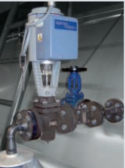
Fig. 32 : Vanne de déconcentration
