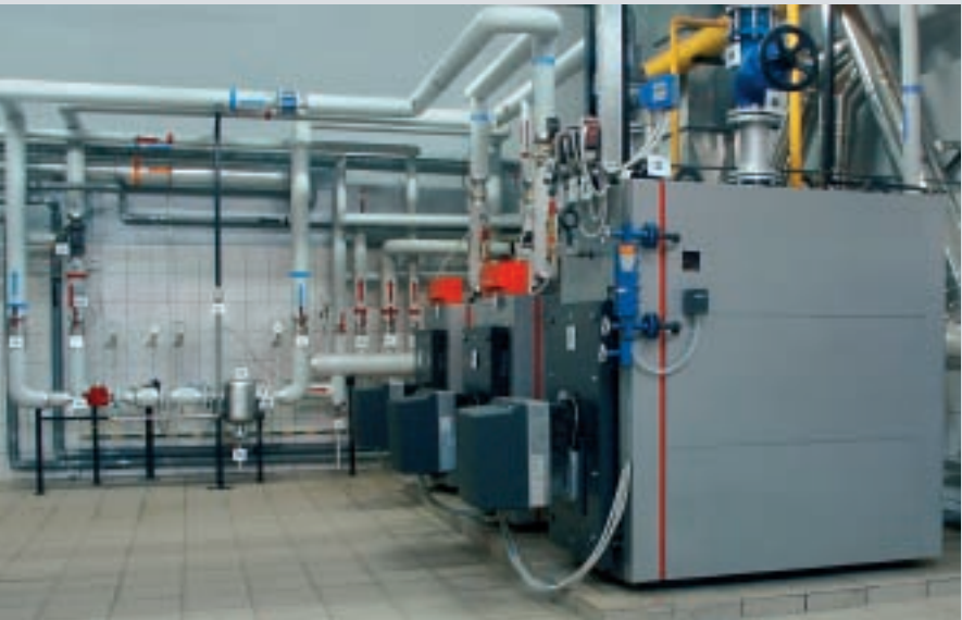
Fig. 15 : Installation équipée de trois Vitoplex - un générateur de vapeur basse pression et deux chaudières à eau chaude
