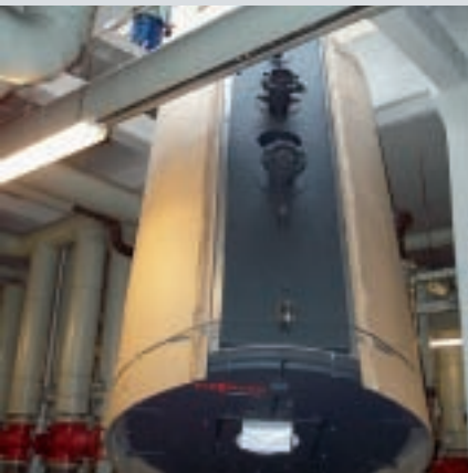
Fig. 83 : Mise en place de la chaudière par le toit
