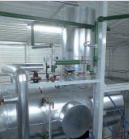
Fig. 52 : Dégazeur basse pression placé sur une bache alimentaire
