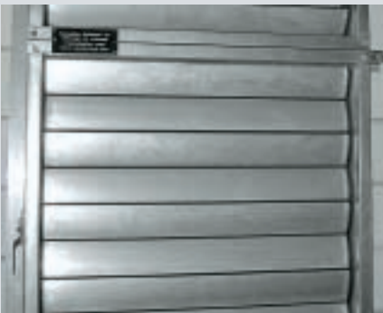
Fig. 77 : Ouverture d'arrivée d'air dans le local chaufferie avec silencieux
