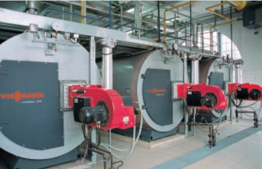
Fig. 71 : Alimentation en vapeur de l'hôpital AMH à Chorzow (Pologne) : trois générateurs de vapeur haute pression Vitomax 200 HS de 2,4 t/h (8 bar) alimentent le chauffage, la blanchisserie et la stérilisation
