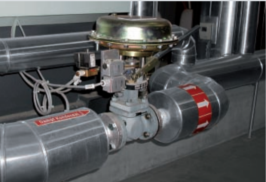
Fig. 31 : Vanne automatique de desembouage périodique de la chaudière
