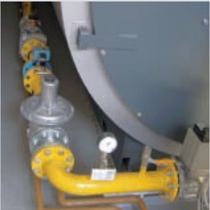
Fig. 23 : Rampe à gaz
