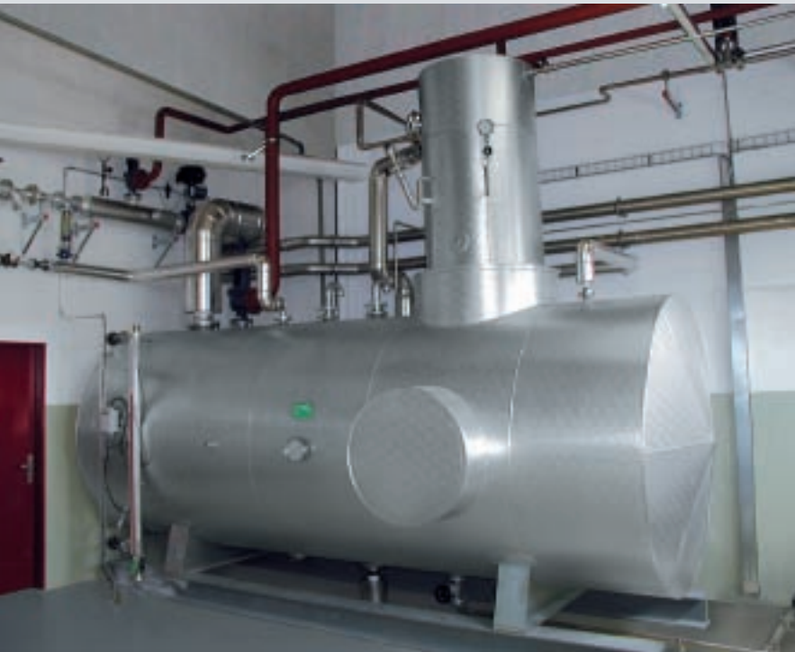
Fig. 56 : Bêche alimentaire avec dégazage thermique
