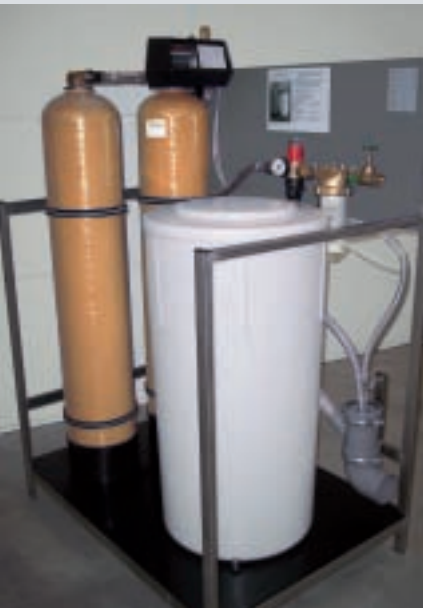
Fig. 48 : Equipement d'adoucissement Viessmann double volumétrique à immersion automatique
