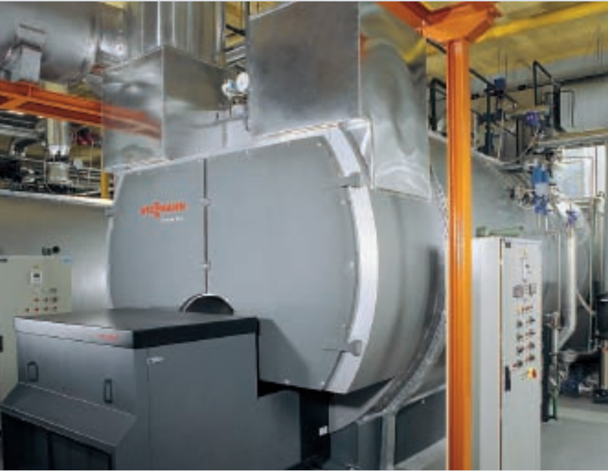
Fig. 91 : Générateur de vapeur Vitomax 200 HS avec récupérateur de chaleur équipant l'hôpital de Maribor, Slovénie (6 t/h, 13 bar de vapeur saturée)
