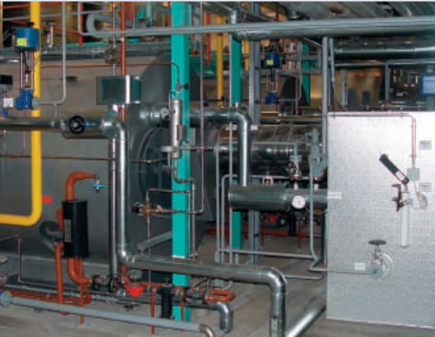
Fig. 43 : Chaudière à vapeur Vitomax 200 HS à économiseur monté en aval (à droite)
