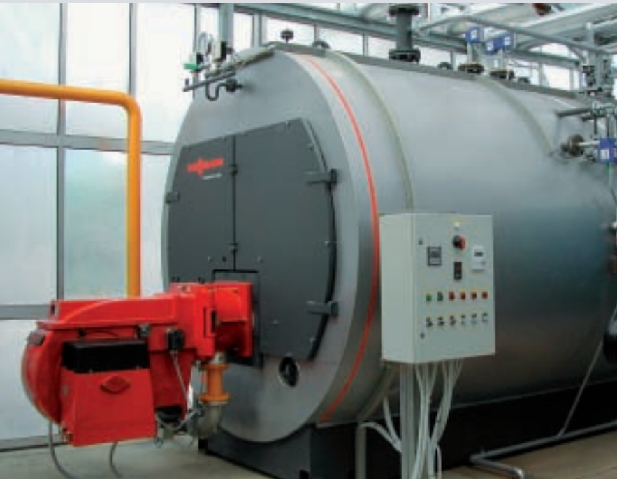
Fig. 64 : Générateur de vapeur haute pression Vitomax 200 HS (4 t/h, horticulture)
