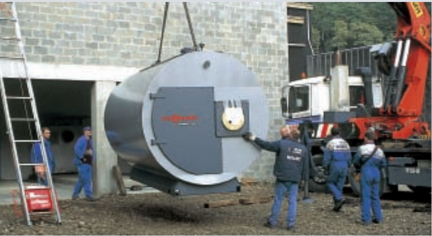
Fig. 80 : La mise en place d'une chaudière de grande puissance exige de l'expérience et du doigté
