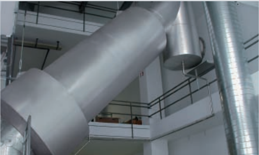
Fig. 74 : Piège à sons côté fumées
