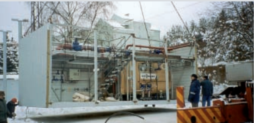
Fig. 84 : Mise en place d'une Vitomax 200 HS (type M237) livrée en container en Estonie
