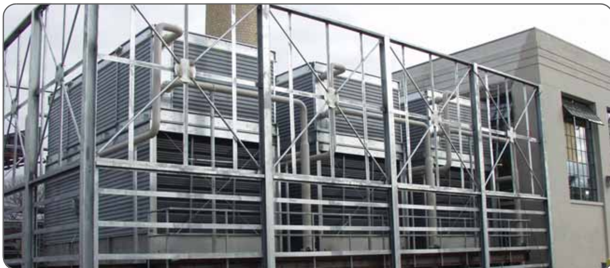
Figure 10 – Murs construits autour des tours de refroidissement à circuit fermé
