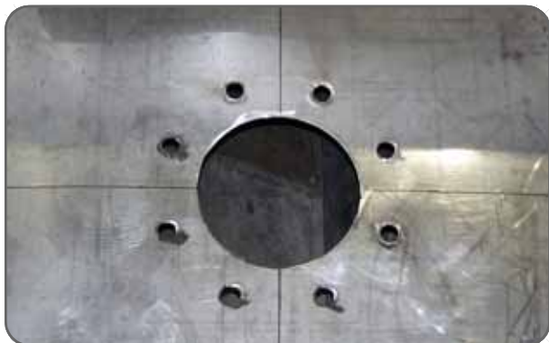
La découpe de la bride plate est illustrée sur ce panneau de bassin d'eau froide pour s'adapter à une bride EN 1092
