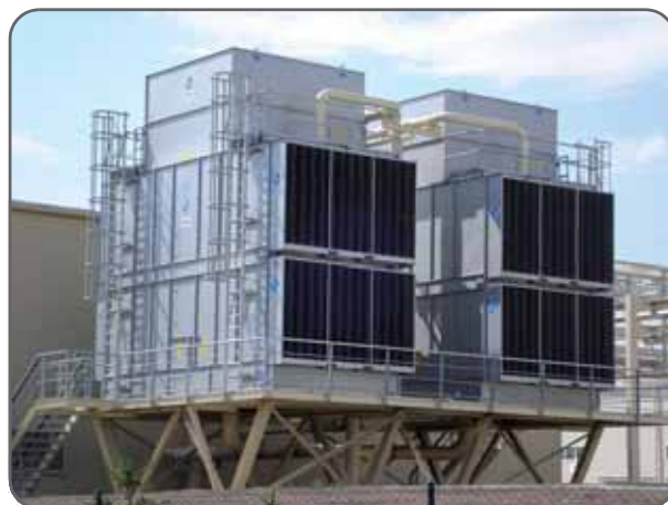
Figure 11 – Atténuateur acoustique à l'aspiration et au refoulement sur une tour de refroidissement BAC de la série 3000
