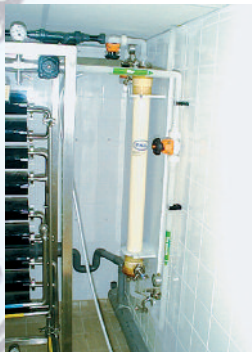
Ultrafiltration, loop output. CH Saint-nazaire.
