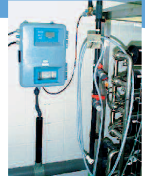
Surveillance et analyse en continue du chlore total et libre
