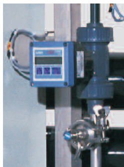
Capteur analogique de débit boucle et prise d'échantillon bactériologique
