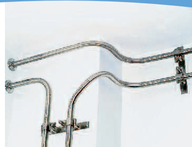
Boucle en inox316L quatité "pharma" sou- dure - TIG orbitale Certifiée CE med
