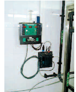
Surveillance et analyse en continue du chlore total et libre
