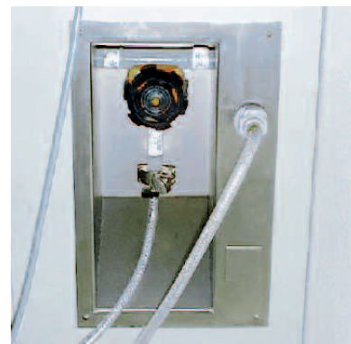
Vanne sanitaire "pharma" sans bras morts en PVDF ou en inox.
